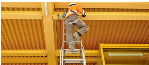
50 Dispositif de protection contre les chutes (protection par encordement). Point d'ancrage au-dessus de la tête.
