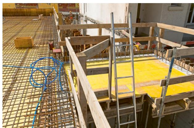
32 L'échelle dépasse d'au moins 1 m le point d'appui supérieur: l'accès est sécurisé.
