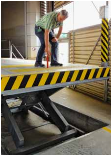
01 // L'accident s'est produit sur une plateforme élévatrice semblable à celle-ci (cette photo n'a pas été prise sur le lieu de l'accident). La goupille de sécurité permet d'empêcher l'abaissement intempestif de la plateforme. // Photos: Suva
