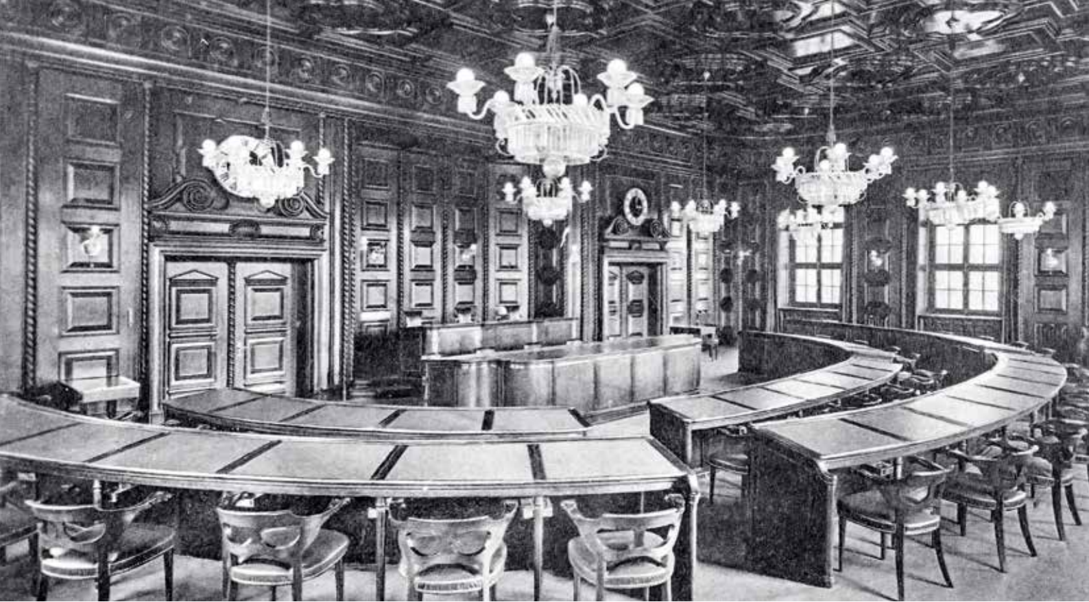
Historische Aufnahme des Verwaltungsratsaals der Suva
