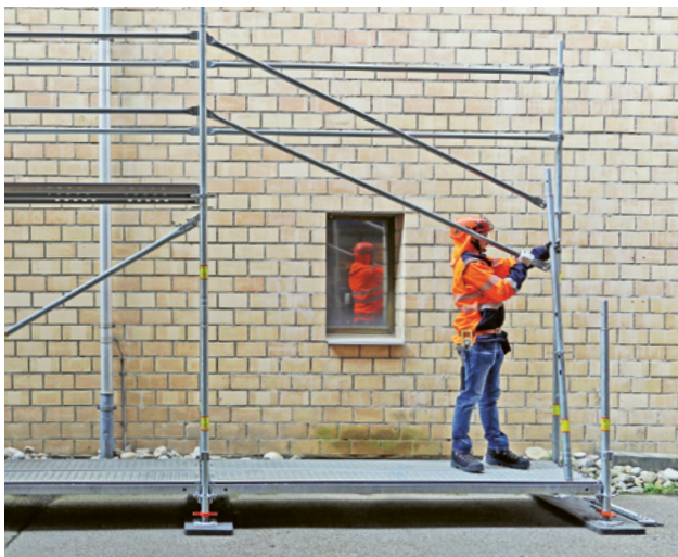
1 Montage des Seitenschutzsystems von der darunterliegenden Ebene aus – am Gerüst verbleibende, vorlaufende Absturzsicherung während Montage, Nutzung und Demontage.
