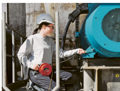
1 Verifica del conduttore di protezione
