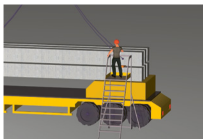
2 Beim An- und Abhängen ab 2,0 m Absturzhöhe Hilfsmittel, lange Anschlagmittel oder Anseilschutz verwenden.
