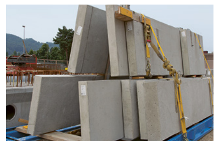
3 Bauteile gegen Umkippen sichern.
