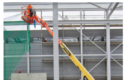
3 Hubarbeitsbühnen einsetzen, statt mit Anseilschutz arbeiten.
