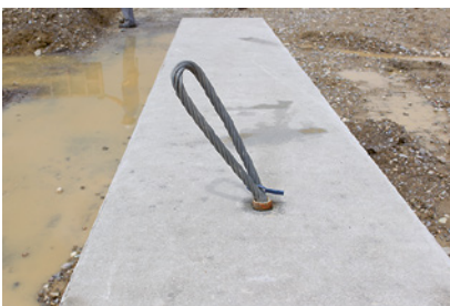
1 Lastanschlagpunkte an vorgängig festgelegten Stellen montieren.
