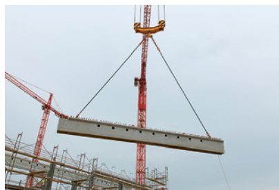
2 Asymmetrische Lasten korrekt anschlagen.
