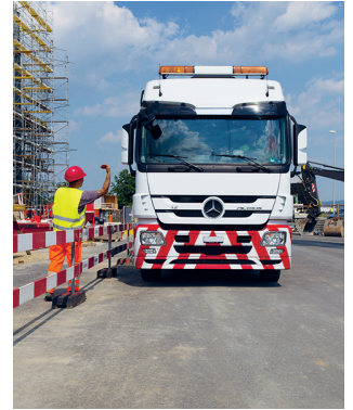
Regel 4 Bauteile sicher abladen und zwischenlagern
