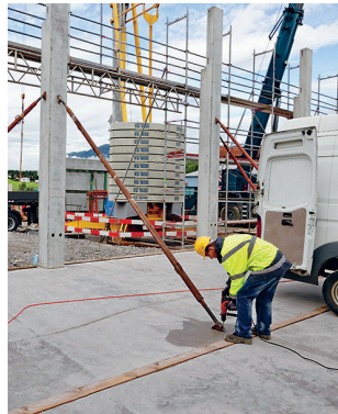
Regel 7 Positionierte Bauteile sichern
