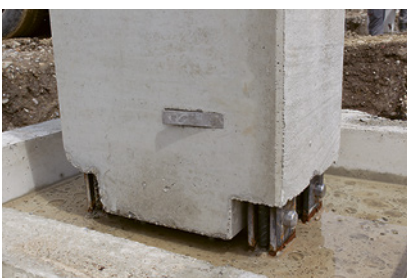
1 Korrekt gesicherte Fussplatte mit total 4 Ankern
