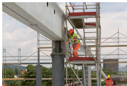
2 Montagearbeiten mit Treppenturm: effizient, sicher und ergonomisch.
