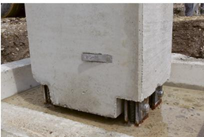
1 Korrekt gesicherte Fussplatte mit total 4 Ankern
