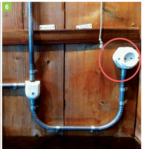
1 Laieninstallation, 2 defektes Sicherungselement, 3 defekte Abdeckungen, 4 alte Scherenleuchte, 5 defekte Sicherung, 6 Porzellan-Steck- und -Abzweigdosen
