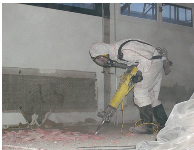
2 Ein Bodenbelag wird mit einem Spitzhammer entfernt.
