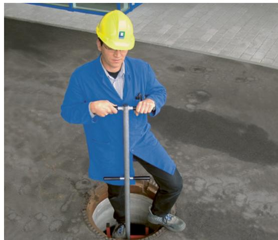
1 Discesa in un pozzo con l'aiuto di un dispositivo di trattenuta
