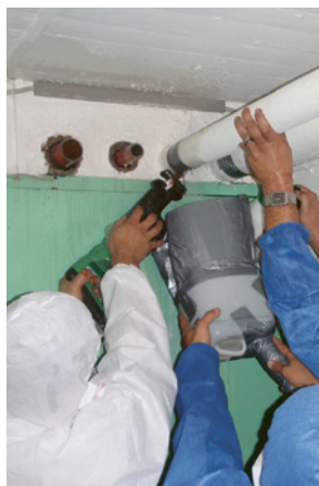
4 Découpage d'un tuyau à la scie égoïne.
