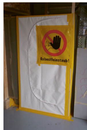
3 La zone d'assainissement est clairement signalée et délimitée.
