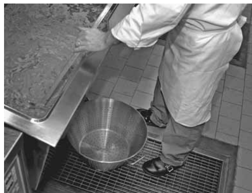
Fig. 1: con i grigliati a filo del pavimento dotati di superficie antiscivolo si evitano incidenti, scivolamenti e inciampi.
