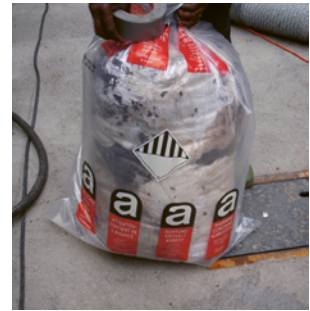
6 Sac en plastique avec marquage «Amiante».
