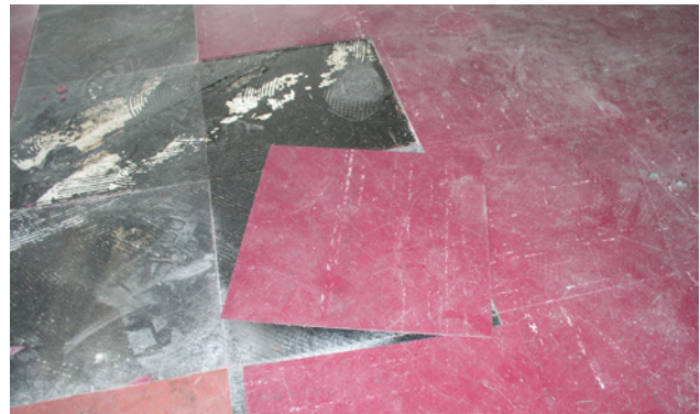
1 Dans les revêtements floor flex monocouches (durs et cassants), les fibres d'amiantes sont intimement liées à la matrice.
