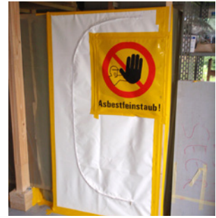
4 La zone d'assainissement est clairement signalée et délimitée.
