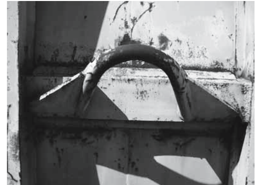
Bild 5: Aufnahmebügel und deren Befestigung sind auf Risse und Verformungen zu kontrollieren.
