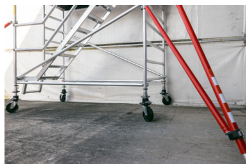
3 Das Rollgerüst steht auf einer tragfähigen Unterlage.
