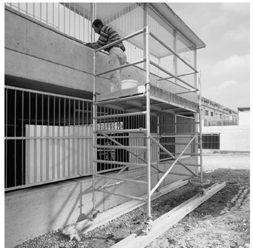
2 Eine tragfähige Unterlage verhindert ein plötzliches Einsinken der Rollen.
