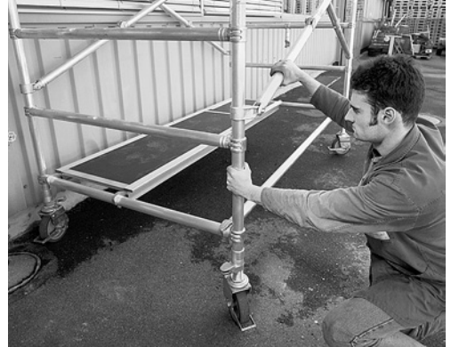
1 Rollgerüste ohne Mängel sind Voraussetzung für sicheres Arbeiten.
