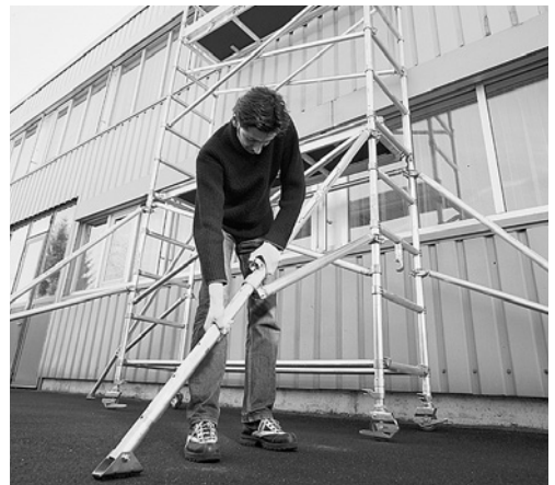
3 In der Montageanleitung steht, ab welcher Höhe die Abstützungen zu montieren sind.
