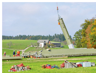
3 Non sostare sotto i carichi sospesi.
