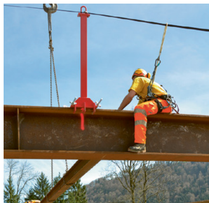
2 Système de montants temporaires pour des ancrages continus.
