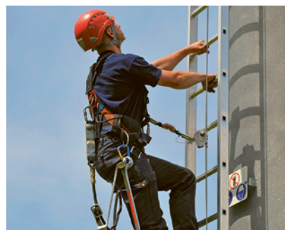
3 Système à glissière de sécurité sur un relais de téléphonie mobile.
