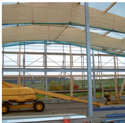
2 Avant de travailler avec une protection par encordement, vérifier l'utilisation des plateformes de travail de levage.
