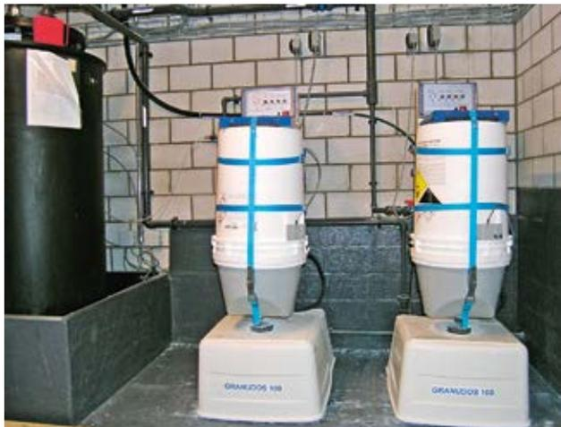
**Fig. 1** Station de dosage d'hypochlorite de calcium. Il est ainsi possible de renoncer au stockage et à l'utilisation de chlore dans des réservoirs sous pression.
