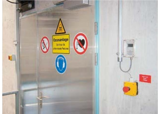
**Fig. 2** Bouton d'arrêt d'urgence à l'extérieur du local d'implantation de l'ozoniseur
