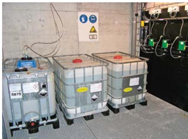
**Fig. 3** Vue d'un local séparé pour le dosage d'acide. Le sol est conçu comme un bac de rétention; dans le coin, le canal d'évacuation de l'air vicié de la ventilation artificielle du local.
