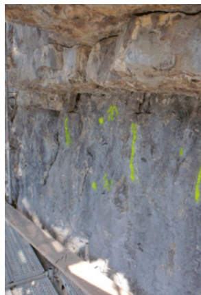
3 Lors des travaux exposés aux dangers naturels, les risques doivent être réévalués en permanence (p. ex. pans de roche risquant de tomber).
