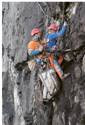
1 La sécurisation des parois rocheuses pose des exigences maximales en matière de préparation du travail et de formation du personnel.
