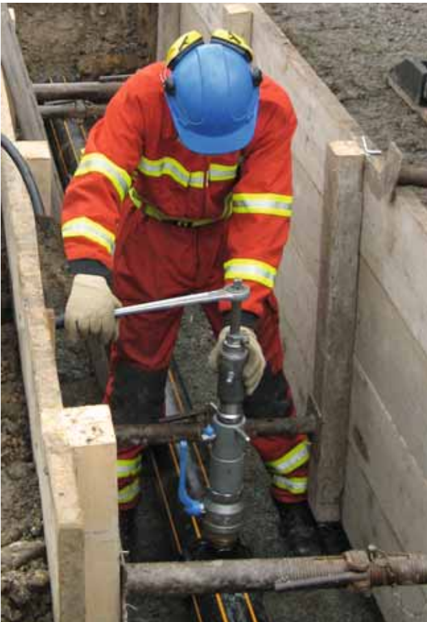
Bild 1 Anbohren mit Schleusengerät
