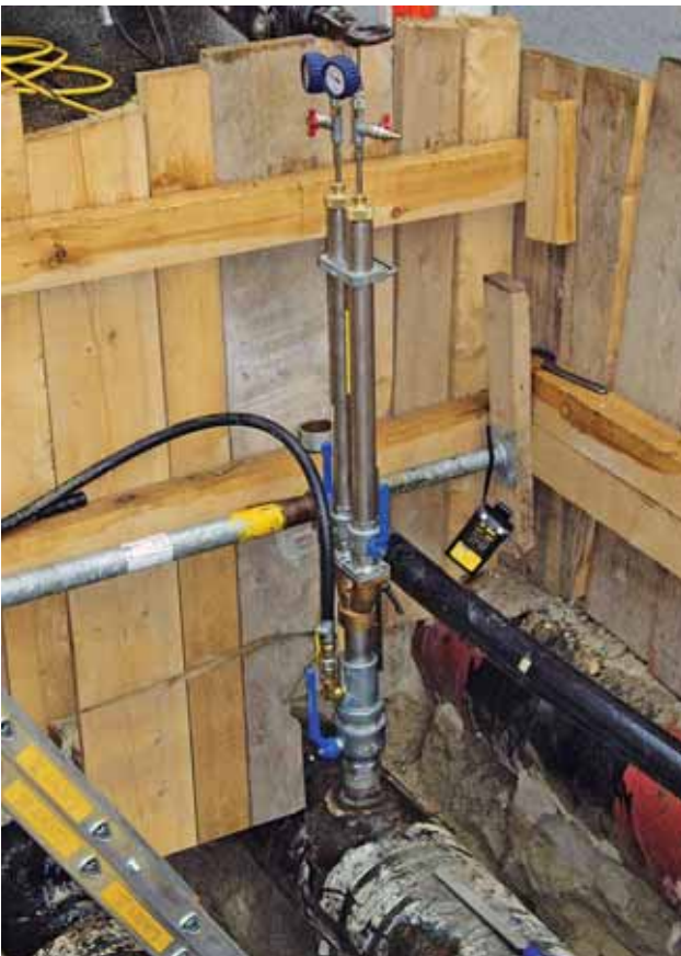
Bild 26 Gasmessung im Arbeitsbereich
