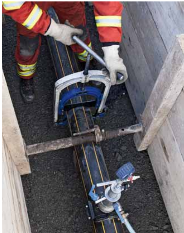
Bild 25 Durchtrennen mit Rohrabstreifer
