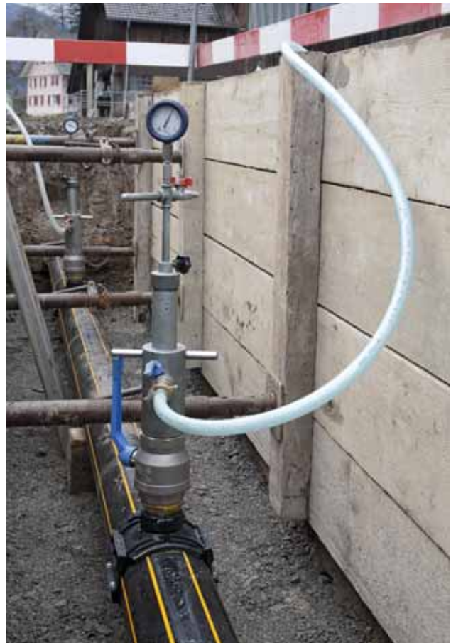
Bild 2 Setzen von Blasen mit Schleusengeräten
