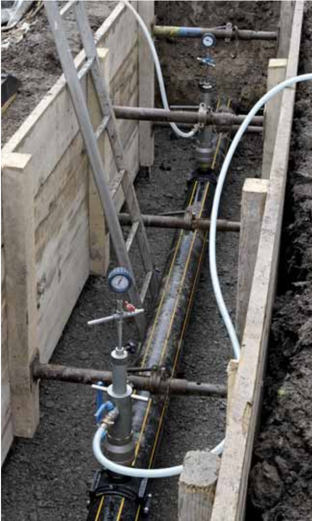
Bild 12 Zwei Einfachblasensetzgeräte mit Vorrichtung zum Spülen des Arbeitsbereichs
