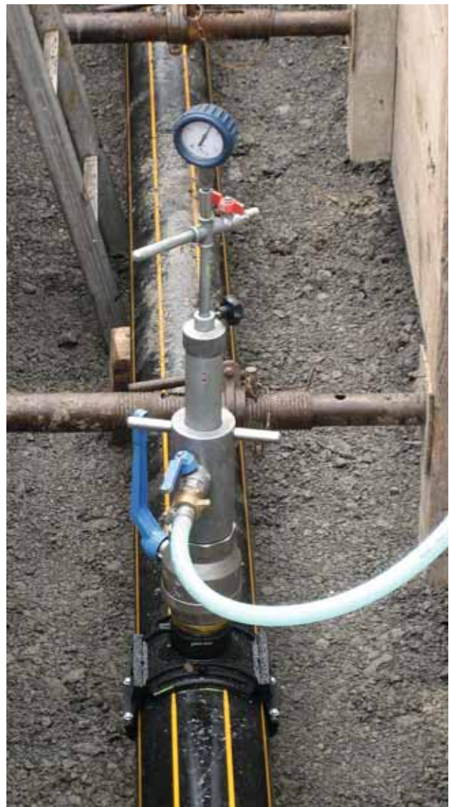
Bild 23 Kontrolle des Drucks in der Blase
