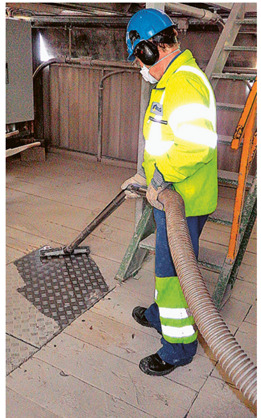
3 Entfernen von Staubablagerungen mit dem Staubsauger
