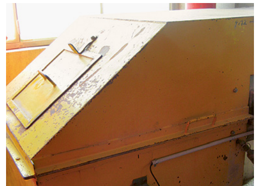
4 Dicht verschlossene Kontrollöffnung
