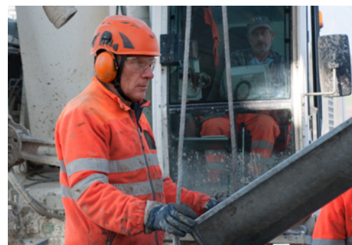
8 Casco, occhiali di protezione, guanti, protettori acustici (ad es. inserti auricolari), stivali di sicurezza e indumenti ad alta visibilità fanno parte dell'equipaggiamento standard dei DPI.
