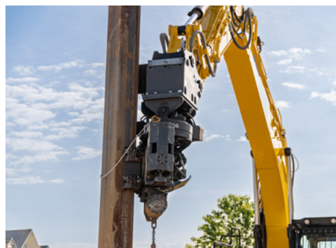
4 Battipalo vibrante: l'apparecchiatura a presa laterale è in grado di sollevare il materiale, fissarlo e poi infilarlo nel terreno in un'unica operazione.
