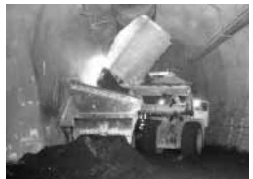
Bild 3: Pneulader beim Schüttern. Bei der Wahl der PFS muss dem harten Einsatz der Geräte Rechnung getragen werden.
