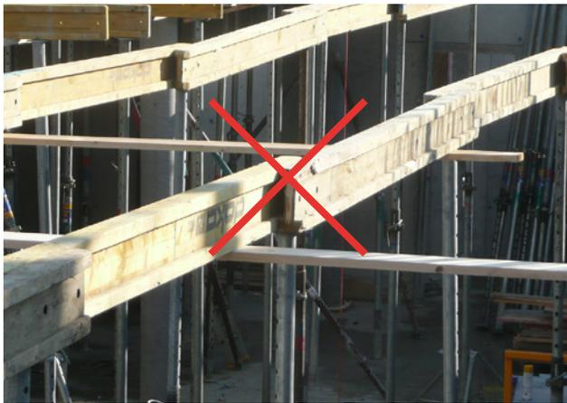
5 Supporti per elementi prefabbricati in calcestruzzo: scarsa stabilizzazione, puntelli non verticali, assenza delle teste a forcella
