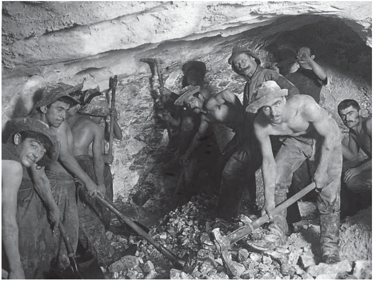
Un groupe d'ouvriers en plein travail dans le tunnel du Simplon. Tout ou presque se faisait à la main et l'on était loin des prescriptions actuelles de la Suva... Photo: archives de Peter Jäger.
