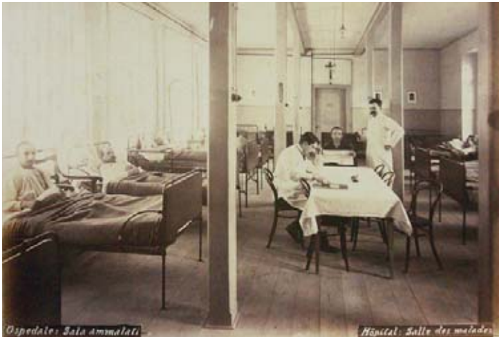
Vue de l'intérieur de la salle des malades de l'hôpital de l'entreprise de construction du tunnel du Simplon. Sur 3445574 jours de travail, Daniele Pometta a enregistré 52677 jours de maladie, soit 1,53%.
