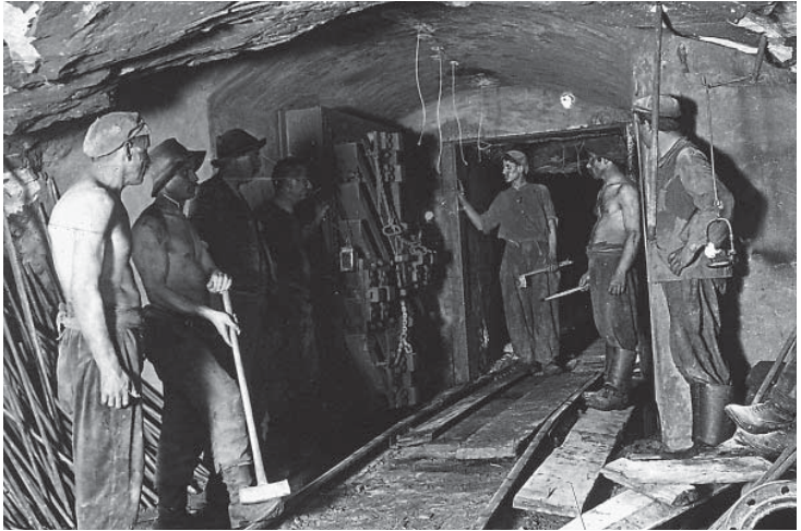
Mineurs posant devant la porte de fer érigée à l'intérieur de la galerie du Simplon. Construite le 28 mai 1904 dans la partie nord du tunnel, cette porte empêchait les masses d'eau d'envahir les galeries. A partir de cette date, ce seront les équipes travaillant du côté sud qui se chargeront de la poursuite du percement. Photo: archives de Peter Jäger.
