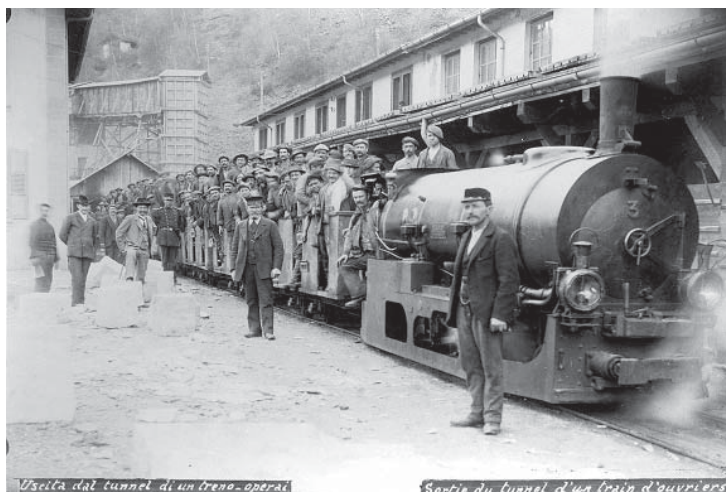
Uscita dal tunnel di un treno-operai Sortie du tunnel d'un train d'ouvriers Changement d'équipe. Le train véhiculant les ouvriers chargés du percement du tunnel (env. 450 hommes par équipe) quitte les galeries.
