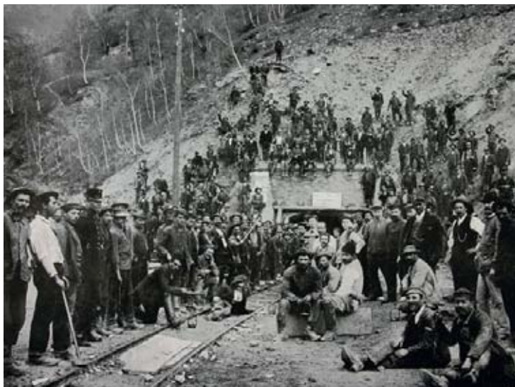
Ouvriers au travail vers 1899 devant la galerie nord du tunnel du Simplon. La main-d'œuvre se composait en grande partie d'Italiens, mais on y trouvait aussi quelques mineurs suisses, notamment des Valaisans et des Tessinois.
