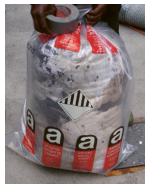
6 Sacco di plastica con la dicitura «Amianto»
