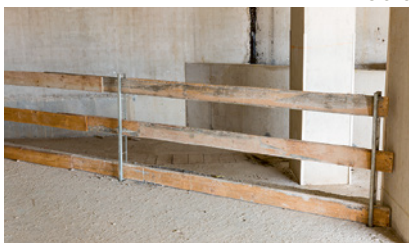
1 Grande ouverture avec garde-corps en trois parties
