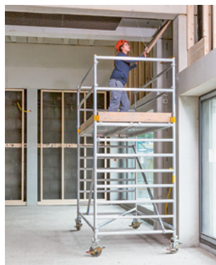
Règle 3 Utiliser des échafaudages sûrs
