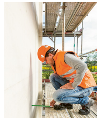
Règle 4 Contrôler les échafaudages chaque jour
