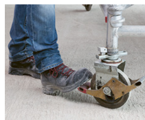
4 Échafaudage roulant bloqué
