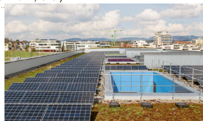
3 Garde-corps périphériques autour des ouvertures dans la toiture
