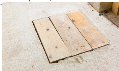
2 Plateaux en bois solidement fixés ou encastrés dans une battue
