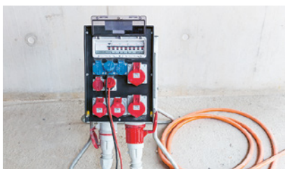
1 Raccorder les machines électriques sur un tableau électrique de chantier.
