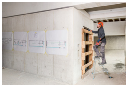
2 Sécurisation d'un puits pour gaines techniques
