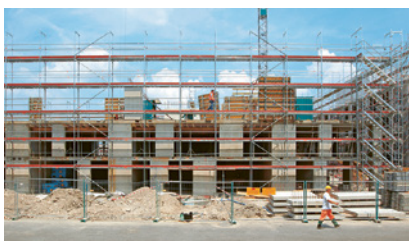
1 Échafaudage de façade
