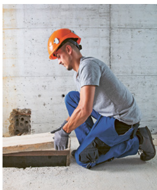
Règle 5 Sécuriser les ouvertures dans les sols et les toitures
