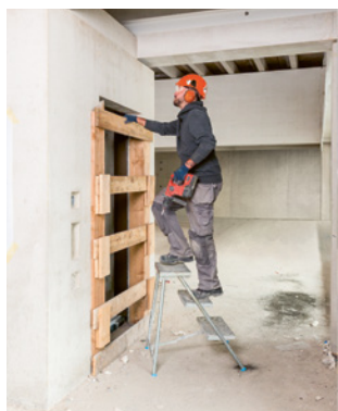
Règle 6 Sécuriser les ouvertures dans les parois
