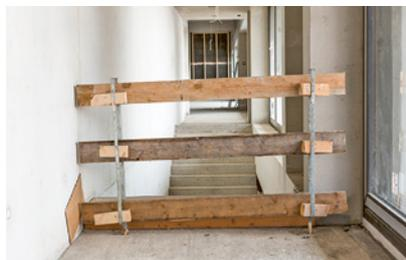
2 Garde-corps utilisé pour sécuriser une zone à risque de chute
