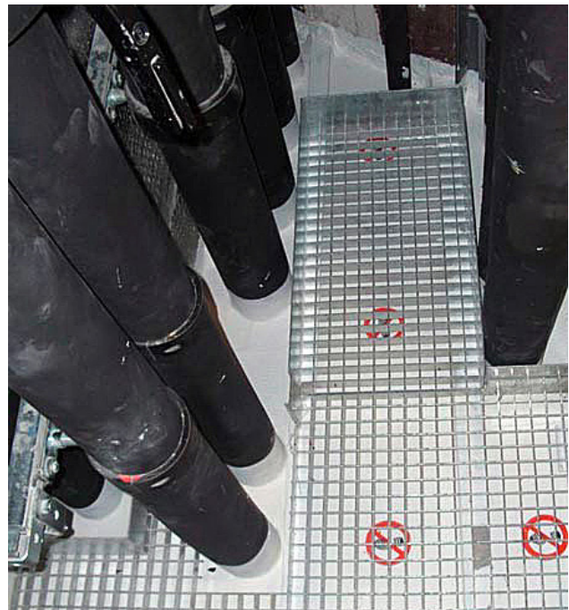
2 Durchbruchssichere und begehbare Brandabschottung
