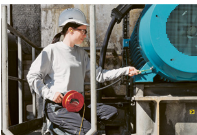
1 Prüfung des Schutzleiters
