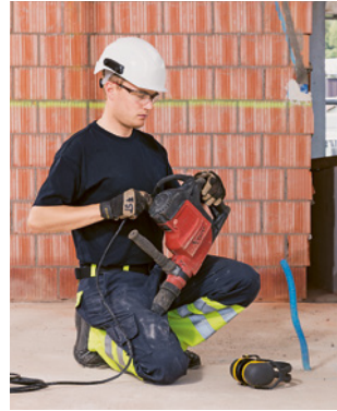
Regel 3 Sichere Arbeitsmittel verwenden
