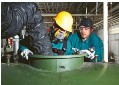
1 Lavori di molatura in una cisterna pulita: ventilazione e protezione delle vie respiratorie sono necessarie.
