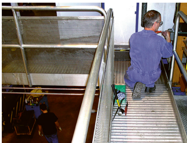
20 Parapetto su una piattaforma di lavoro con bordi di arresto al piede e griglia di riempimento a maglie strette lungo il lato rivolto verso il vuoto. Questa struttura impedisce che una persona accovacciata oppure degli oggetti possano precipitare sulla via di circolazione sottostante.
