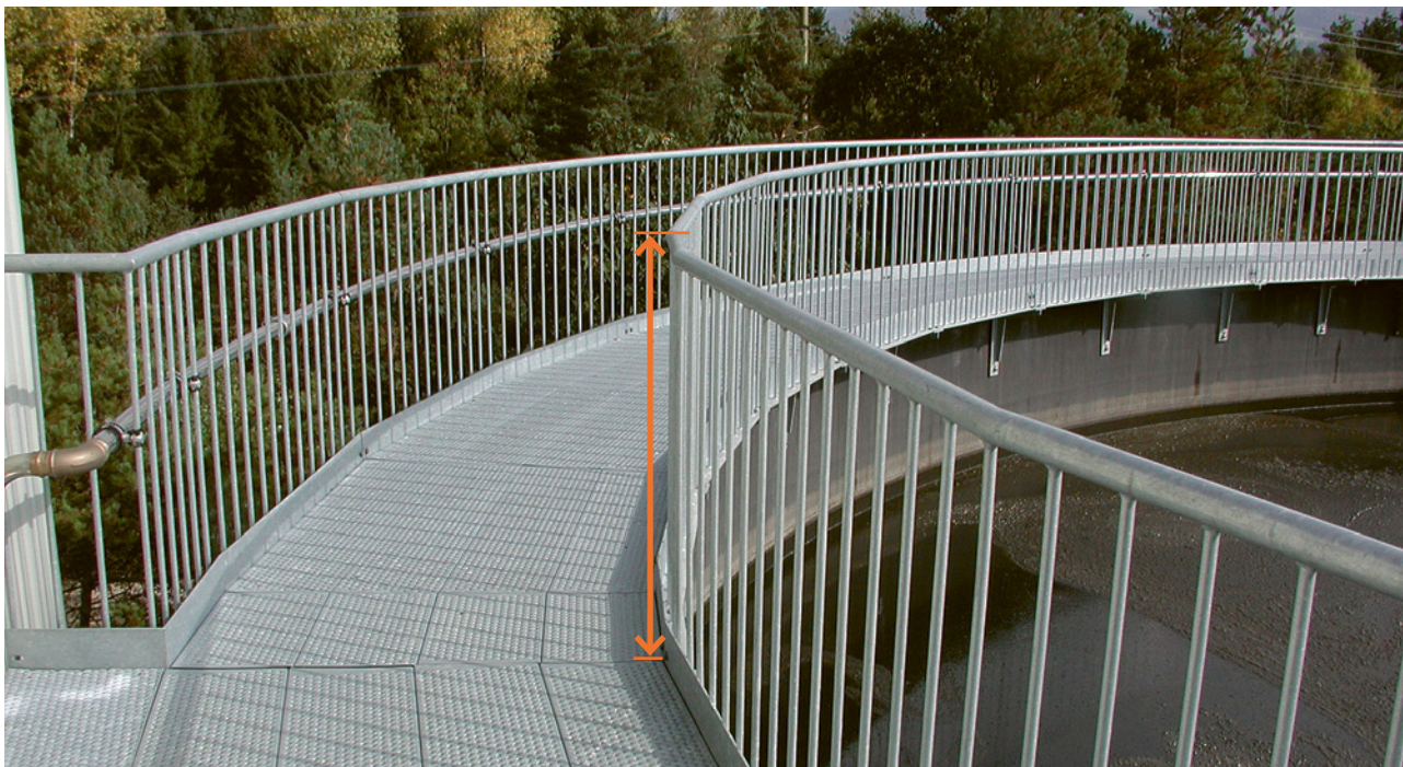
10 L'altezza del parapetto è di 1,10m calcolata dalla superficie di calpestio allo spigolo superiore del corrimano.
