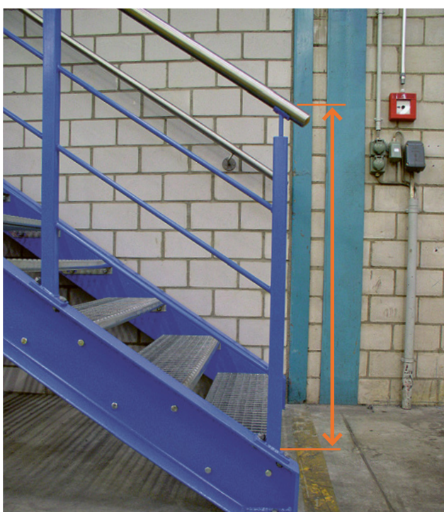
11 Lungo le scale l'altezza del parapetto deve essere compresa fra 0,90m e 1,0 misurando dallo spigolo del gradino allo spigolo superiore del corrimano.
