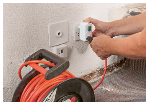
6 In mancanza di un interruttore FI, collegare un interruttore FI (salvavita) mobile.
