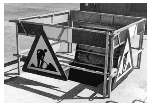
5 Sbarramento di uno scavo; i pericoli che derivano dallo svolgimento dei lavori presso il cliente devono essere minimizzati in collaborazione con quest'ultimo.
