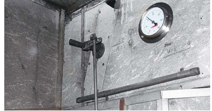
Lüftungskanal aus Asbestzementplatten
