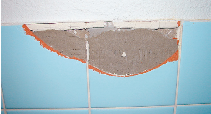
<1 % Chrysotil-Asbest im Kleber
