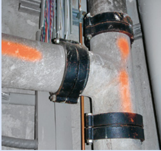
Asbestzement-Rohre
