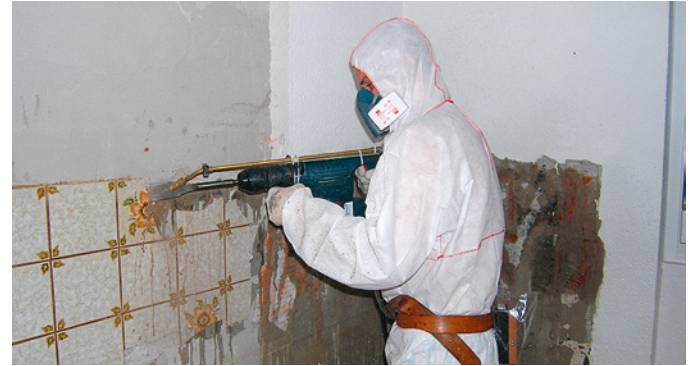
Platten nass entfernen/abschlagen (<5 m 2 )
