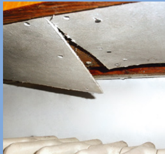
Asbesthaltige Leichtbauplatten
