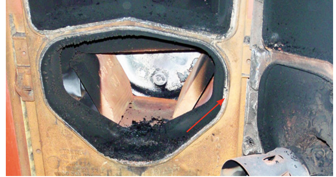
Asbestschnur als Dichtung
