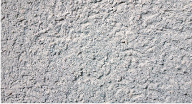
Asbesthaltiger Akustikputz/Abrieb
