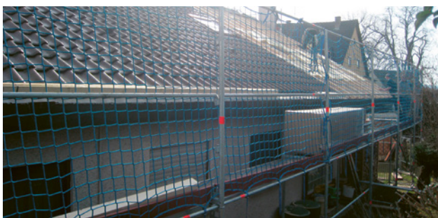
3 Paroi de protection de couvreur correctement réalisée avec des filets de sécurité.
