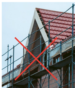
6 et 7 Incorrect: parois de protection de couvreur inefficaces.
