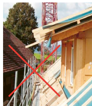
6 et 7 Incorrect: parois de protection de couvreur inefficaces.
