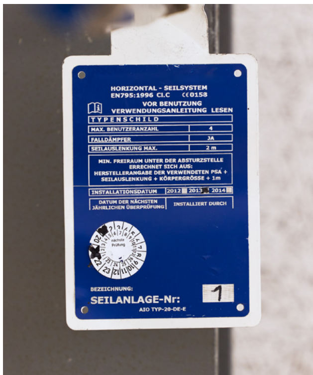
46 Plaque signalétique d'un dispositif d'ancrage fixé à demeure avec plaquette de contrôle
