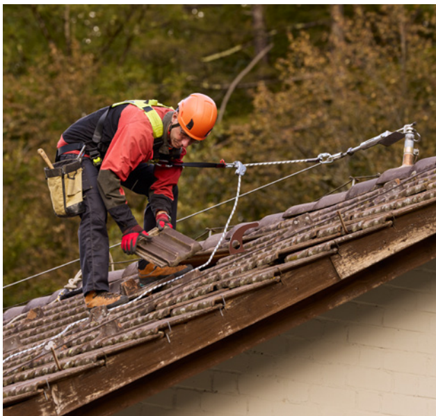
6 Exemple de système d'arrêt des chutes
