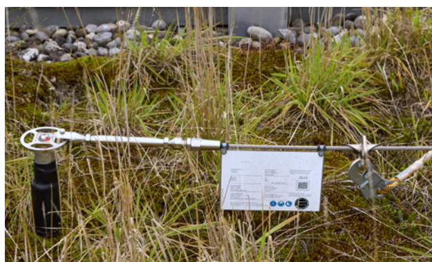
44 Dispositif d'ancrage fixé à demeure avec support d'assurage flexible et points d'ancrage mobiles
