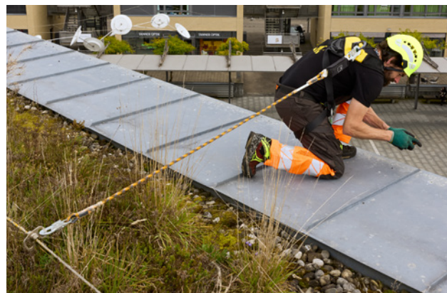
4 Exemple de système de retenue
