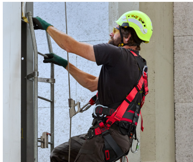
26 Antichutes mobiles avec support d'assurage flexible en câble métallique (SN EN 353-2)
