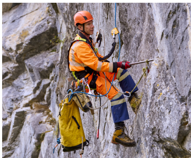
7 Travaux sur cordes (TAPC) avec système d'assurage et de travail
