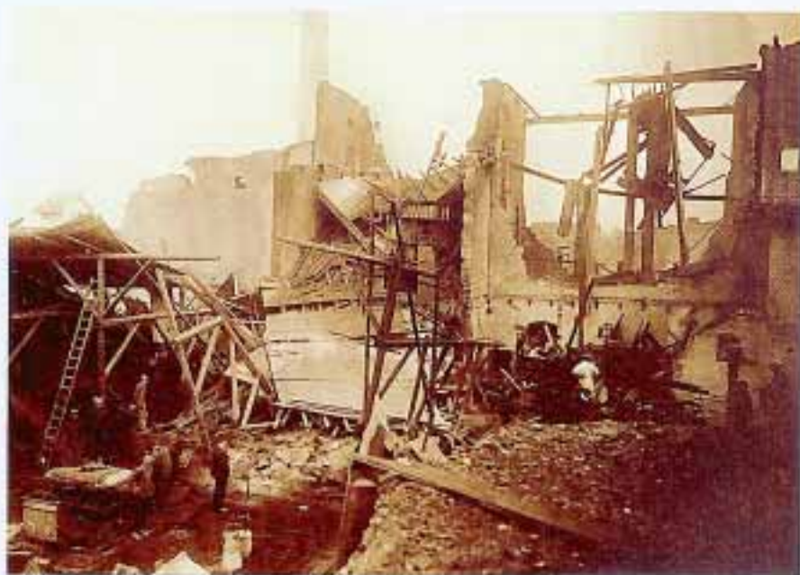
Unfallanalyse 1920 nach einer Kohlenstaubexplosion bei der Briketherstellung. Die Explosion hatte 6 Todesopfer und 12 Verletzte gefordert. Die SUVA-Fachleute klärten von Anfang an die Ursachen von Unfällen ab, um inskünftig ähnliche Ereignisse möglichst zu verhindern.
