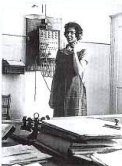
Haustelefonzentrale der Kreisagentur St. Gallen 1926.
