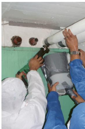
4 Sezionamento di un tubo con segaccio elettrico
