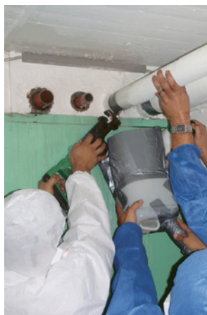
4 Sezionamento di un tubo con segaccio elettrico
