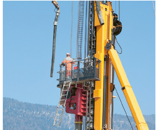
1 Unterhaltsarbeiten können von einem Arbeitskorb aus erfolgen.
