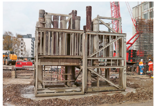
2 Vorbildliche Lagerung von Schüttröhren.
