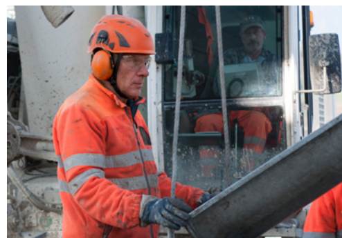
8 Helm, Schutzbrille, Handschuhe, Gehörschutz (z. B. Pfropfen), Sicherheitsstiefel und Warnkleidung gehören standardmässig zur PSA.
