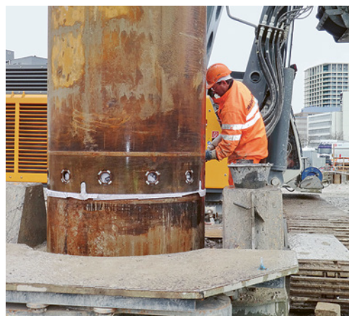
4 Beim Zusammenfügen von Ausrüstungsteilen sind Hände und Füsse besonders gefährdet.
