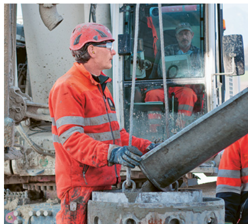
6 Helm, Schutzbrille, Handschuhe, Gehörschutz (z. B. Pfropfen), Sicherheitsstiefel und Warnkleidung gehören standardmässig zur Persönlichen Schutzausrüstung.
