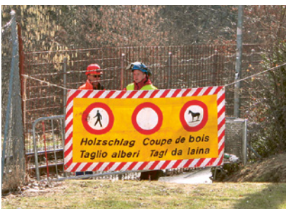
1 Absperrung eines Fusswegs mit einer Absperrplane
