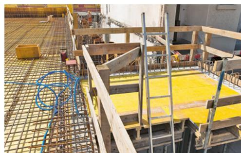
8 Cette échelle dépasse d'au moins 1 m le point d'appui supérieur et des garde-corps permettent de la quitter en toute sécurité.
