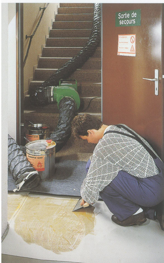
Figura 1: Applicazione di una colla a base di sovente in uno scantinato prima della posa del pavimento. Tubo d'aspirazione e ventilatore del tipo protetto contro le esplosioni.
