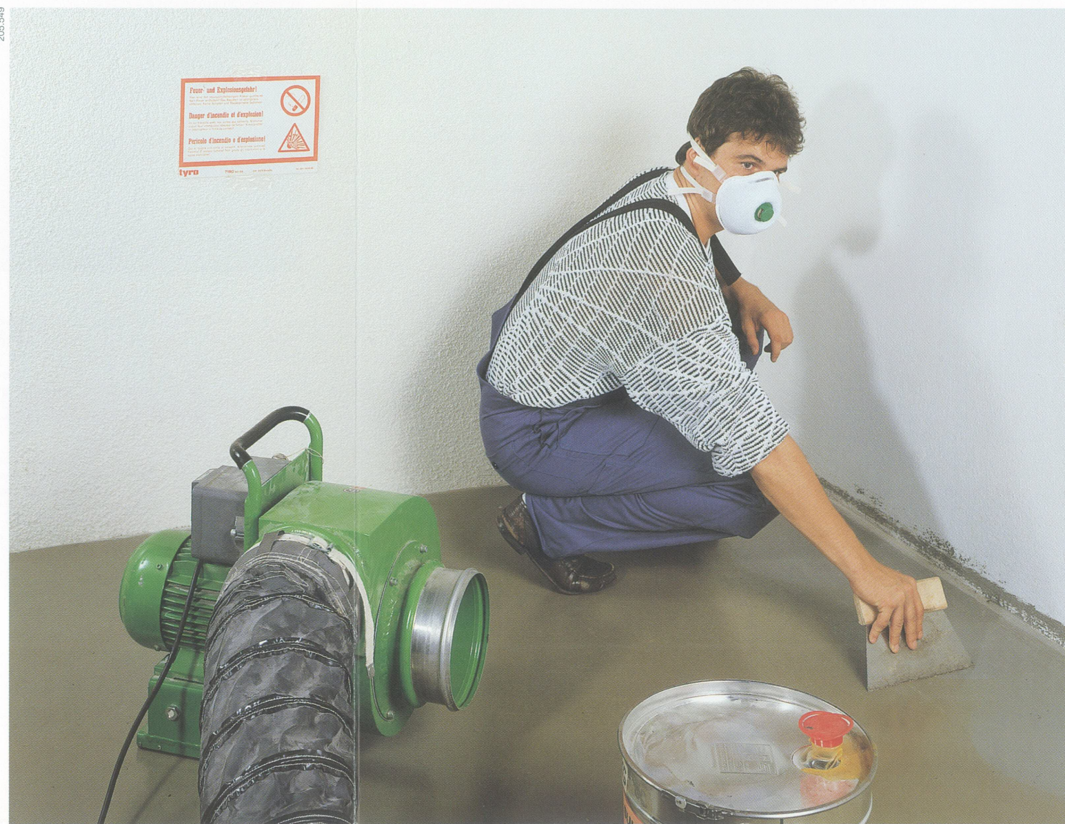
Figura 3: La maschera con filtro a carbone attivo impedisce la penetrazione dei vapori di solvente nelle vie respiratorie. La si deve indossare laddove l'aspirazione è insufficiente.
