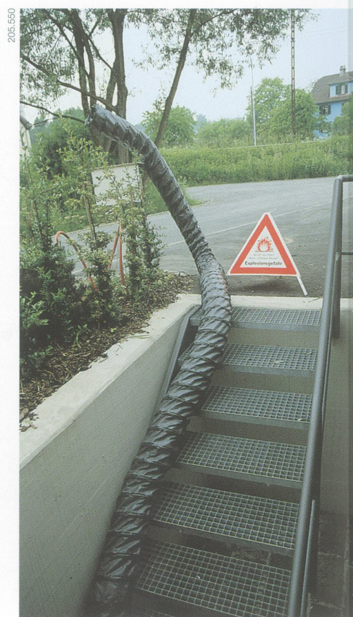
Figura 4: Zona di pericolo: triangolo d'avvertimento e sbarramento davanti allo sbocco esterno dei vapori di solventi. Anche il posto di lavoro deve essere sbarrato e segnalato nello stesso modo.
