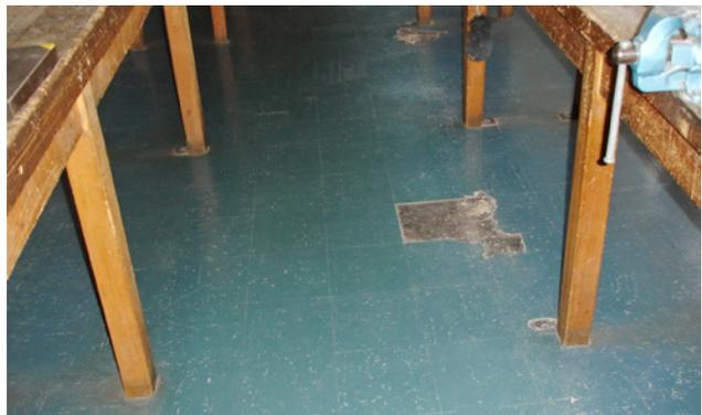
1 Revêtements floor flex monocouches. Les fibres d'amiante sont intimement liées à la matrice.
