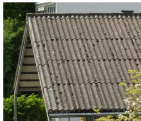
1 Fibrocemento: lastre per tetti
