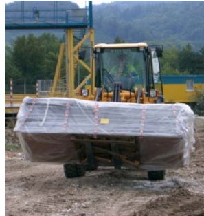
3 Amianto in matrice compatto imballato in sacchi o su paletta con pellicola di plastica
