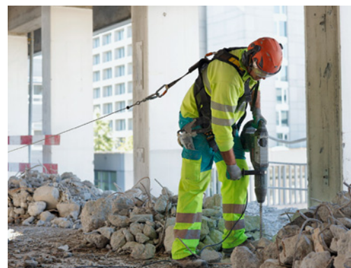
4 Travailleur protégé par un EPI antichute lors du montage du garde-corps périphérique.
