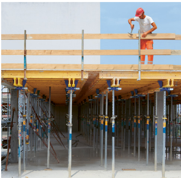
3 Garde-corps périphérique avec montants à pince
