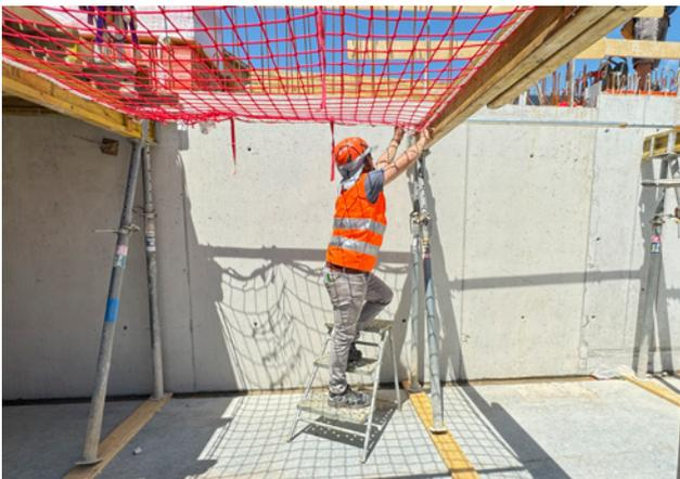
4 Einhängen von Auffangnetzen mit Hilfe eines Tritts.
