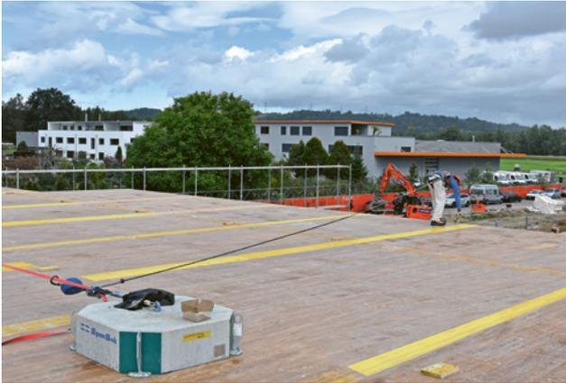
3 Schalen mit geprüftem und zertifiziertem Anschlagssystem.
